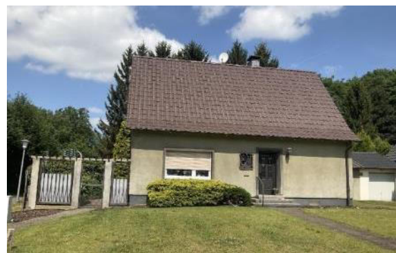
Abbildung 15: Siedlungshaus an der Stallhermstraße
