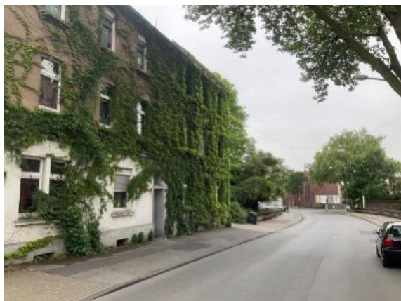
Abbildung 4: Teilraum 1 – Gründerzeitliche Gebäude an der Grabenstraße
