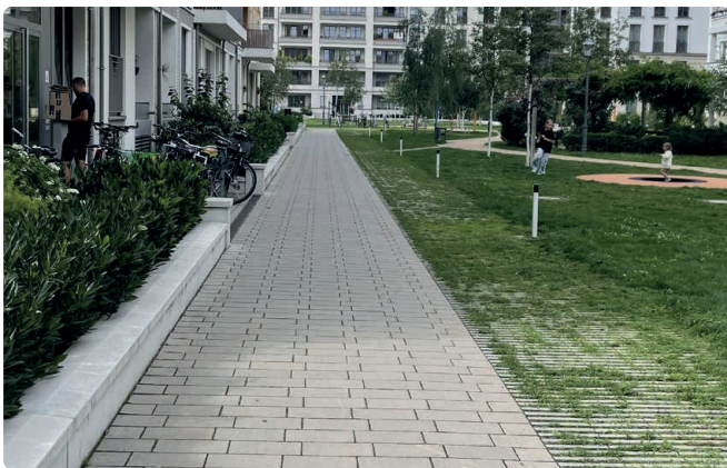
Abb. 117: Rasenfugenpflaster für Feuerwehraufstellflächen
