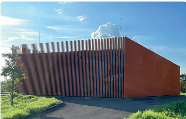
Abb. 91: Hochwasserpumpanlage Kuhlenweg, Köln-Langel
