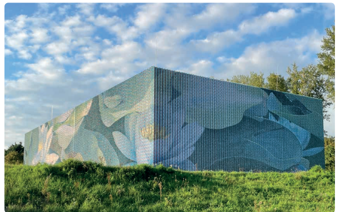
Abb. 92: Hochwasserpumpanlage Kuhlenweg, Köln-Langel
