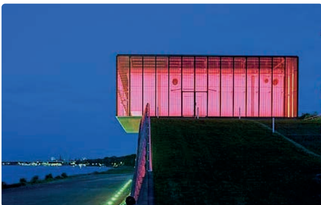
Abb. 94: Hochwasserpumpanlage Schönhauser Straße, Köln
