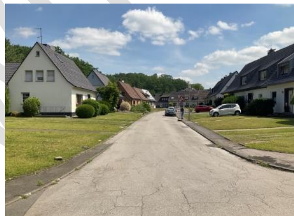
Abbildung 10: Teilraum 7 – Siedlungshäuser der 1950er Jahre mit tiefen Vorgärten, Stallhermstraße
