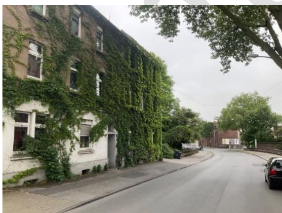
Abbildung 4: Teilraum 1 – Gründerzeitliche Gebäude an der Grabenstraße
